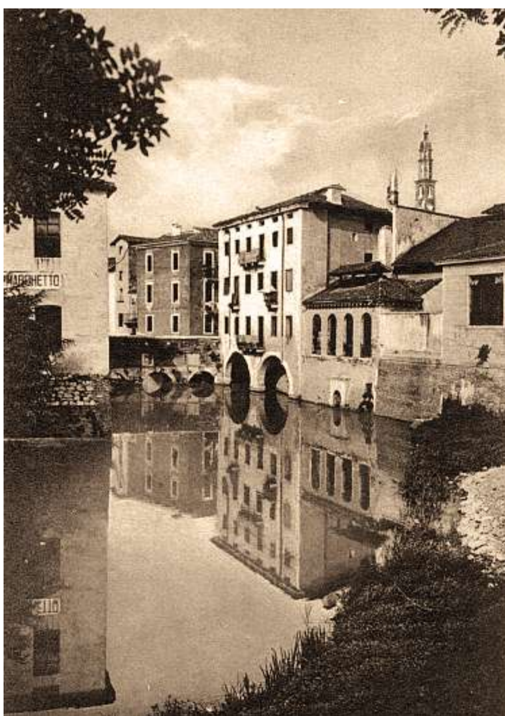
Ponte delle Barche dopo la grandiosa opera idraulica che attorno al 1880 separò Bacchiglione e Retrone
